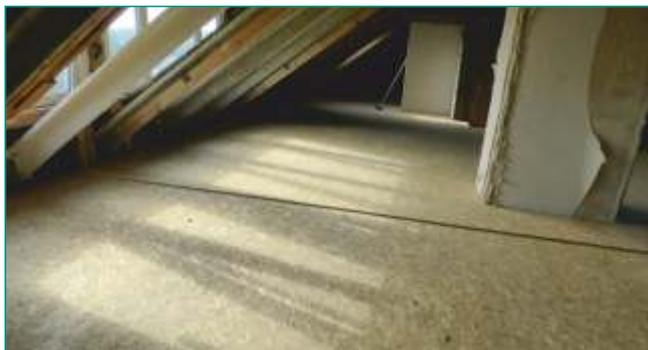
Nach dem Schleifen dieser Wohnungen haben wir in diesen Bereichen, sowie auf den Dachböden der Objekte Fischerring 38-42, Gartenstraße 7-9 und Gerhart-Hauptmann-Ring 10-12, eine Dämmung der obersten Geschossdecke vorgenommen. Diese Dämmung ist begehrbar ausgeführt, damit die Bewohner die Dachböden weiter nutzen können.
