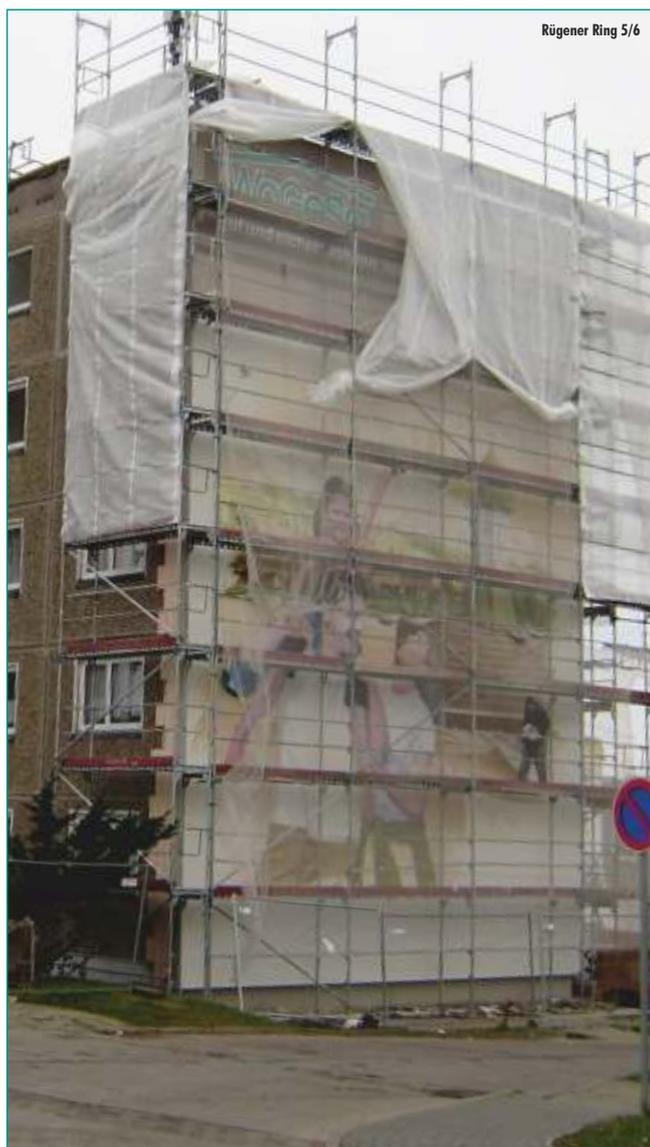
Ein wesentlicher Schwerpunkt unserer Investitionstätigkeit im Jahr 2014 wird der Teilrückbau und die Modernisierung des Wohnobjektes Rügener Ring 15-18 sein. An diesem Objekt werden wir 2 Etagen einschließlich der alten Balkone komplett abreißen lassen.
